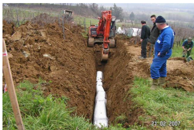
▲ Trincea a sezione ristretta con minimi volumi di scavo in vigna
