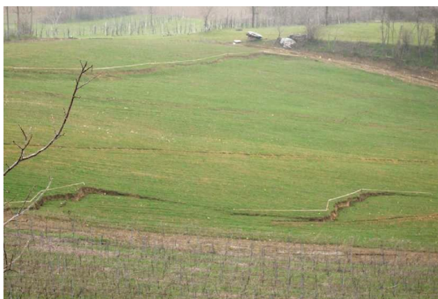
▲ Zona sommitale della frana
