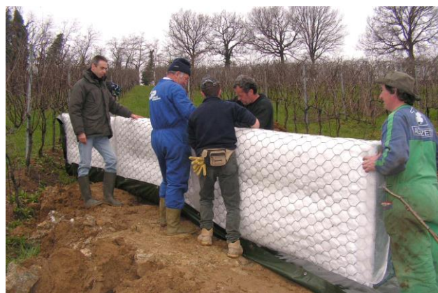
▲ Montaggio della linea drenante a pannelli GABBIODREN®
