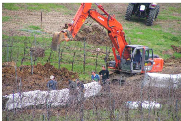
▲ Operazioni di scavo in vigna
