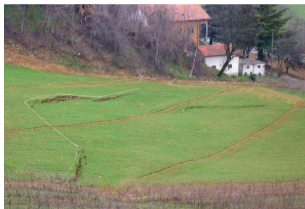
▲ Scarpate di frana che insistono sulla strada S.P.513R
