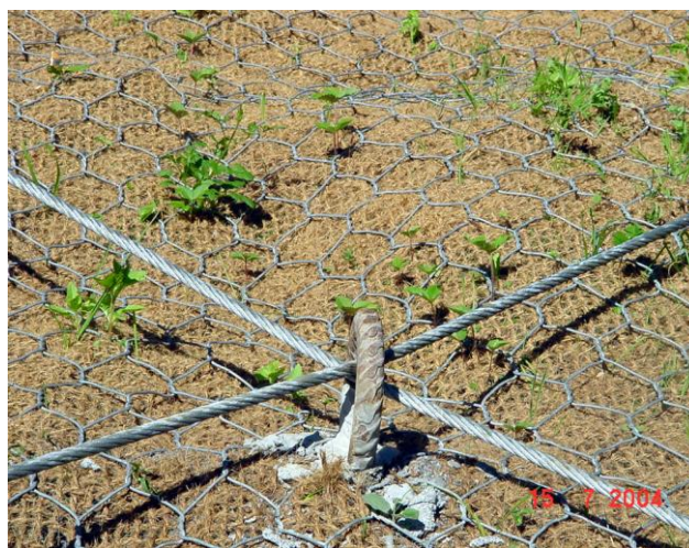
▲ Particolare del golfare e delle funi passanti
