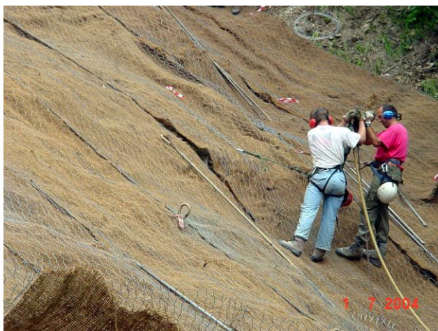
▲ Realizzazione dei fori per le chiodature
