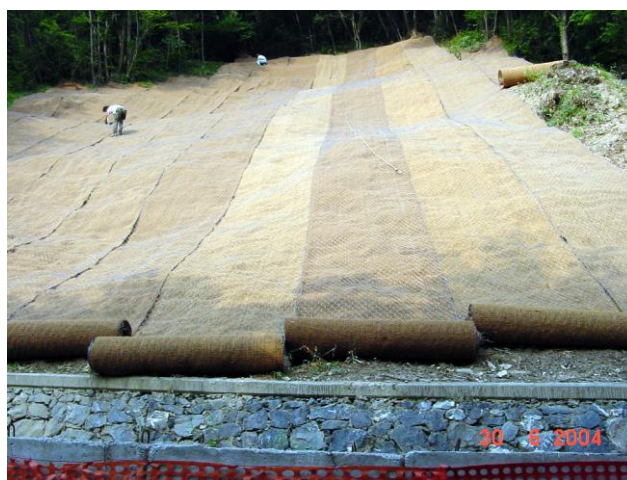
▲ Stesa di tutti i rotoli di geocomposito
