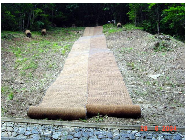
▲ Inizio stesa del geocomposito antierosivo R.E.C.S.®
