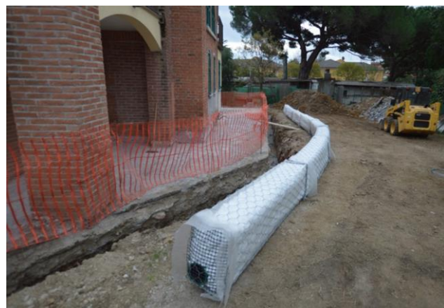
▲ Posa in opera di linea drenante da 0.5m di altezza
