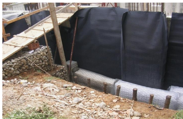
▲ Linea drenante realizzata su edificio in costruzione
