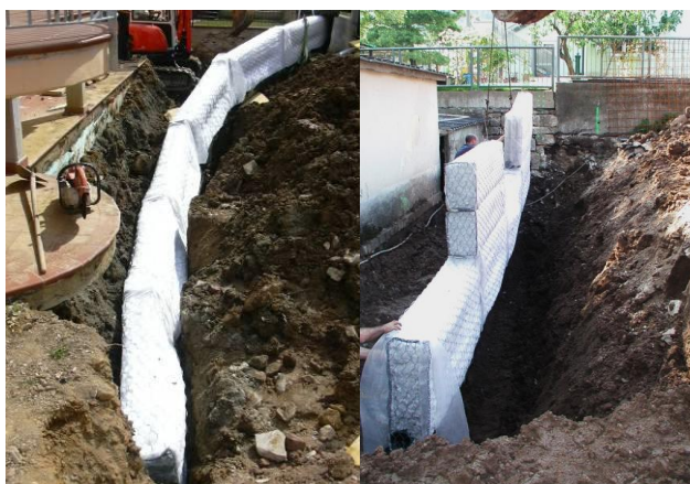
▲ Posa in opera di linee drenanti da 1m e 2m di altezza
