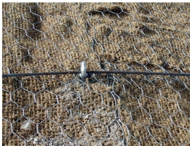
▲ Particolare della fune mediana passante all'interno del golfaro
