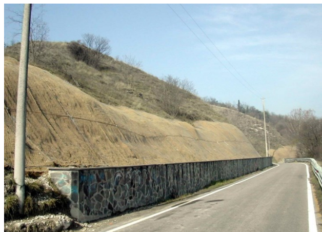
▲ Situazione della strada a lavori ultimati
