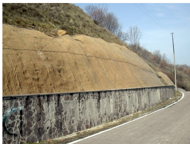
▲ Situazione successiva alla posa in opera
