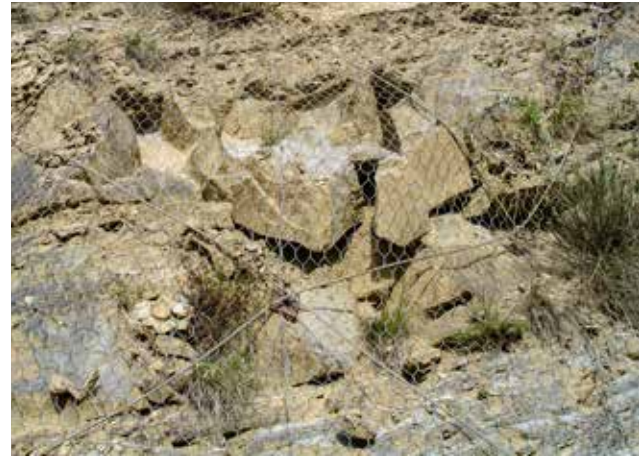
La foto mostra l'effetto di ritenzione della rete e del reticolo di funi su blocchi distaccati
