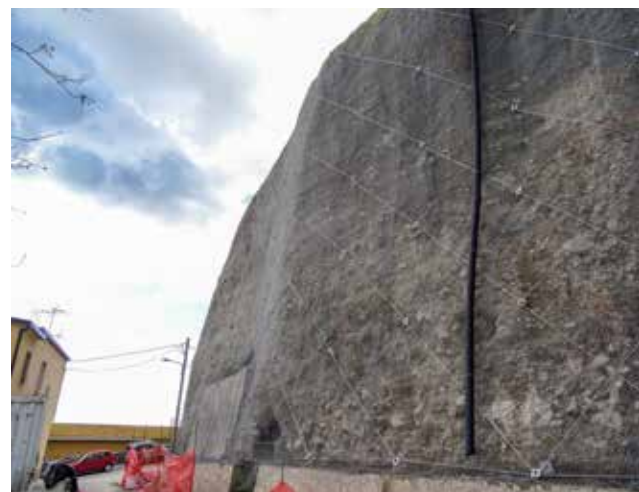
Fasi realizzative di un intervento di rafforzamento corticale a difesa di un abitato
