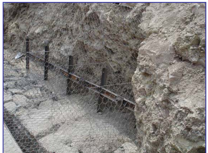
▲ Fasi realizzative del secondo ordine di gabbioni e chiodature
