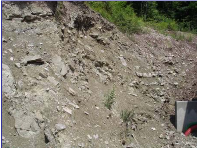
▲ Situazione iniziale della scarpata
