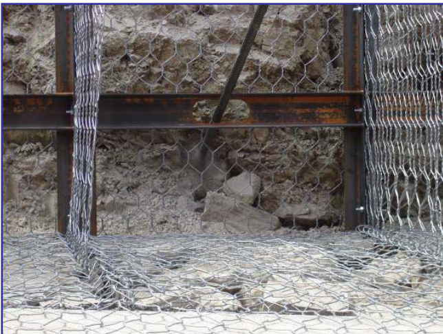
▲ Realizzazione delle chiodature con barre autopercoranti cave \Phi=32e/20i
