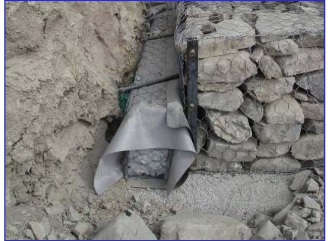
▲ Dettaglio del drenaggio Gabbiodren™
