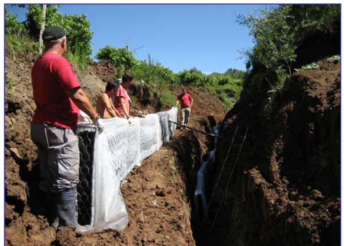
▲ Fasi di posa della trincea Gabbiodren™
