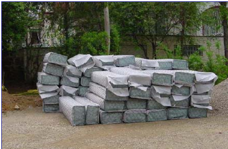
▲ Area di stoccaggio materiali del cantiere. Si notino la pulizia e ordine del cantiere necessarie in zone residenziali e di pregio
