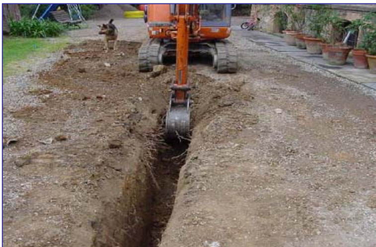
▲ Realizzazione dello scavo per l'alloggiamento della trincea Gabbiodren™
