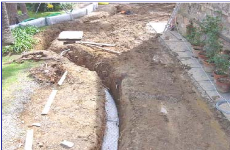
▲ Posa dei pannelli della trincea
