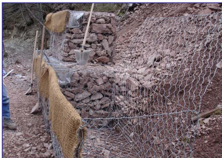
▲ Fasi di assemblaggio e riempimento dei gabbioni a sostegno della pendice detritica
