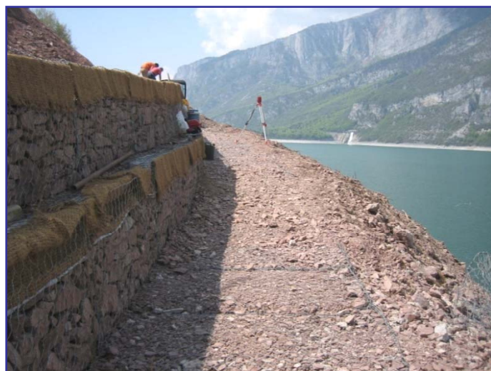
▲ Nella foto è visibile la platea di fondazione in gabbioni e le gabbionate rinverdite in costruzione
