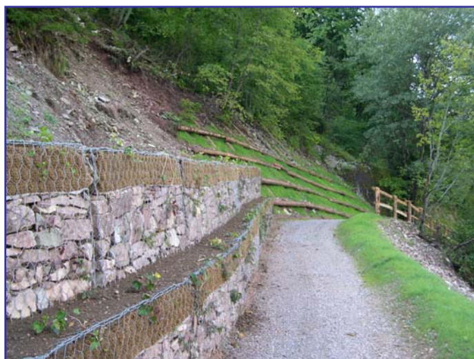
▲ Situazione della pista a lavori ultimati
