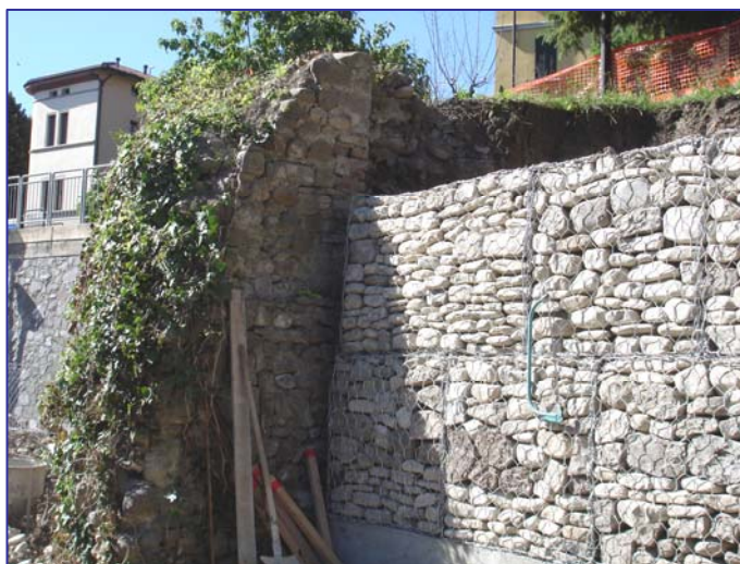
▲ Secondo corso di gabbioni ultimato
