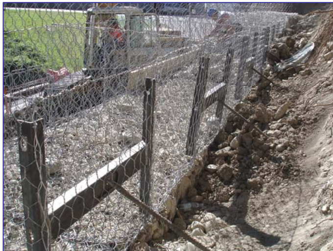
▲ Piastre di ancoraggio e chiodature
