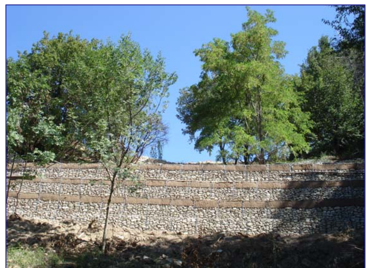
▲ Vista d'insieme dell'opera nelle ultime fasi costruttive
