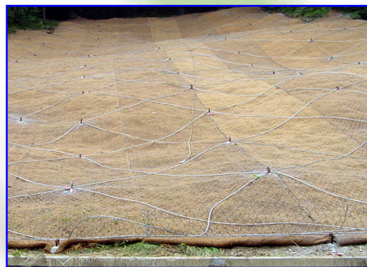
Foto 3 – Reticolo di rinforzo in funi d'acciaio ultimato prima della tesatura
