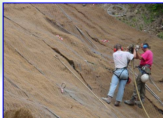
Foto 2 – Realizzazione del sistema di chiodatura
