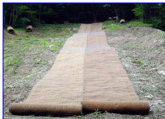
Foto 1 – Fasi iniziali di stesa e posa in opera
