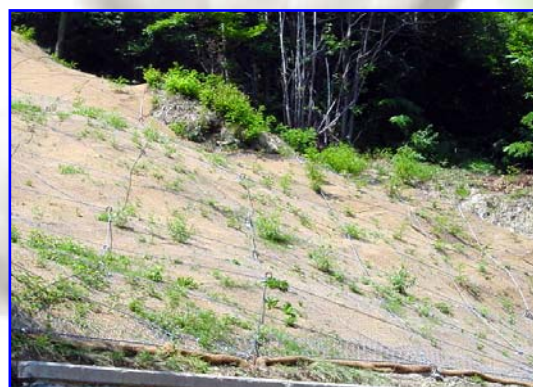
Foto 4 – Lavoro ultimato e prime fasi di rinverdimento
