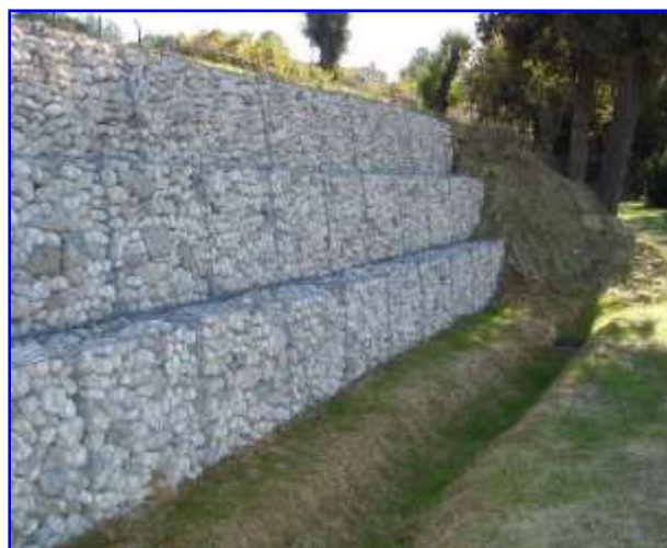
Foto 1 – Muro in gabbioni a consolidamento e drenaggio di un corpo gravitativo di materiali limoso-argillosi saturi.
