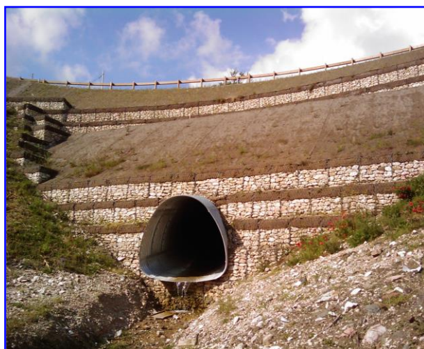
Foto 3 - Opera di consolidamento e rettifica di tracciato stradale realizzata con Nail-Gabions e Gabbioni Verdi
