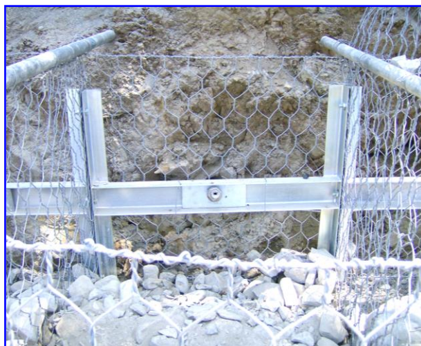
Foto 1 - Dettagli delle strutture di rinforzo e connessione gabbione-chiodo
