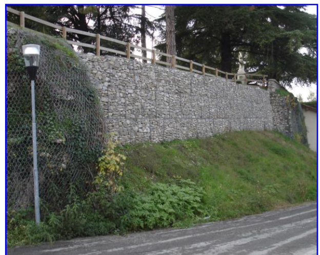
Foto. 1 - Opera realizzata con Nail-Gabions con chiodatura del corso centrale di gabbioni con barre B450C di lunghezza 5 metri e diametro 32mm con testa filettata
