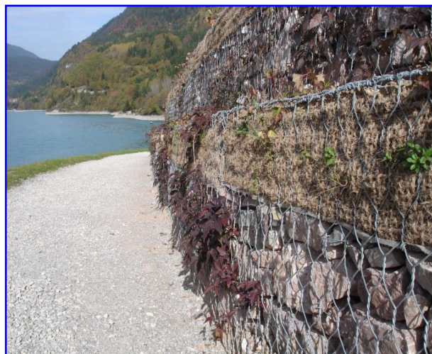
Foto 2 – Piantumazioni di piantine in fitocella all'interno delle tasche vegetative preassemblate
