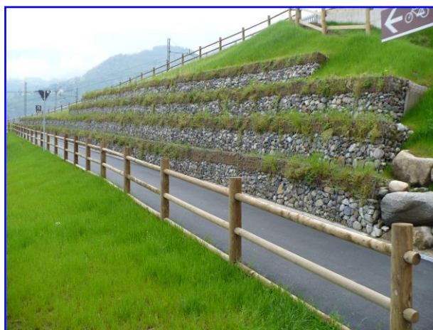
Foto 3 – Gabbionata rinverdita nella prime fasi di vegetazione. Realizzazione pista ciclabile in fregio ad un rilevato ferroviario
