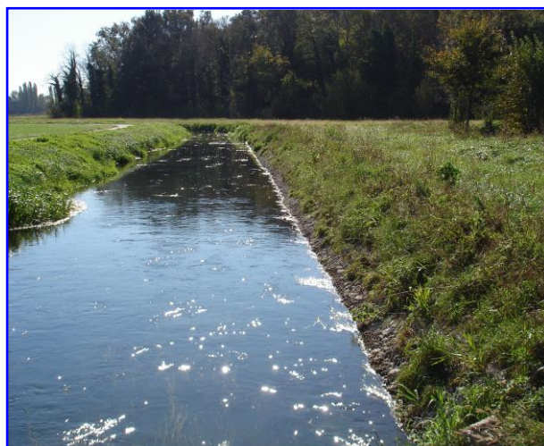
Foto 3 – Opera rinverditata a 5 mesi dal termine dei lavori
