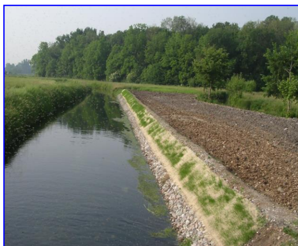
Foto 2 – Opera finita dopo un mese dal termine dei lavori, inizia la germinazione (n.b.: si è eseguita solo una leggera semina a spaglio)
