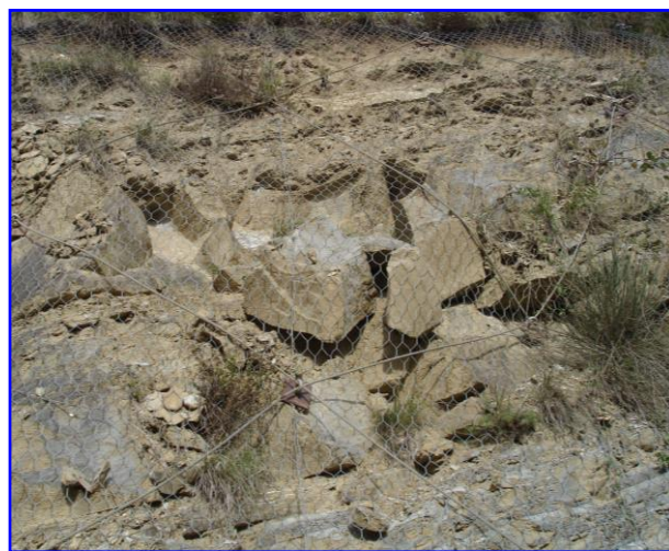
Foto 4 - La foto mostra l'effetto di ritenzione della rete e del reticolo di funi su blocchi distaccati
