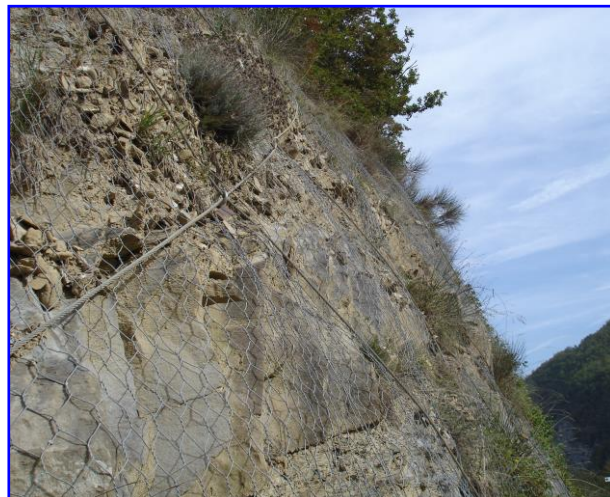
Foto 2 - Dettaglio di un intervento in parete realizzato con rete paramassi, chiodatura e tirantatura con funi in trefoli in acciaio
