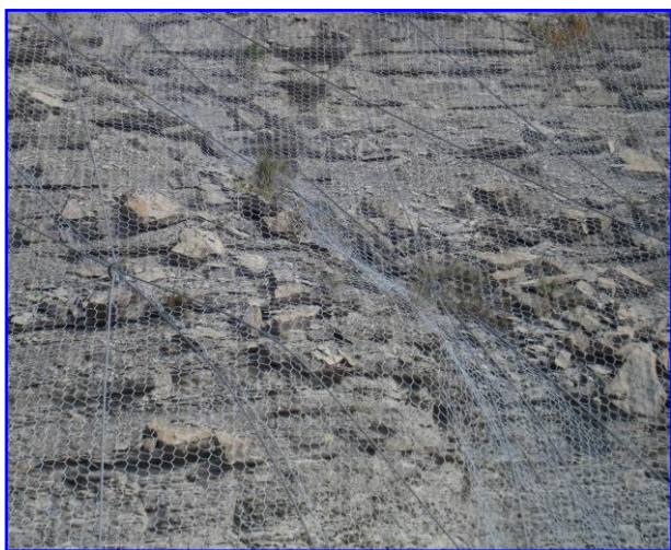
Foto 3 - La foto mostra l'effetto di ritenzione della rete e del reticolo di funi su blocchi distaccati
