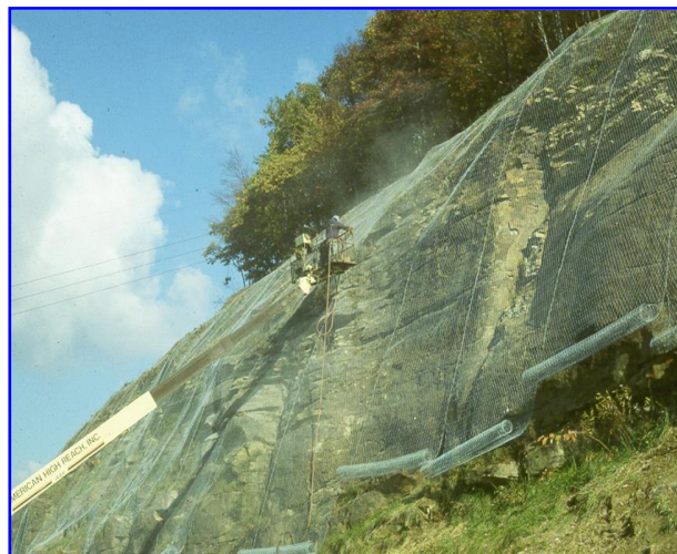
Foto 1 - Installazione di un intervento paramassi in parete, legatura dei teli di rete a doppia torsione
