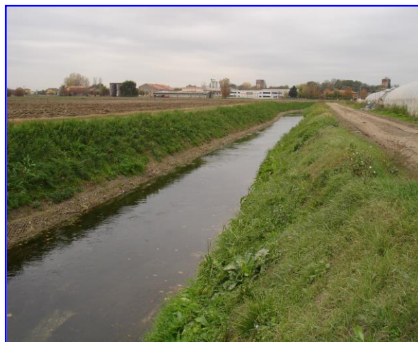
Foto 6 - Situazione del canale dopo l'intervento
