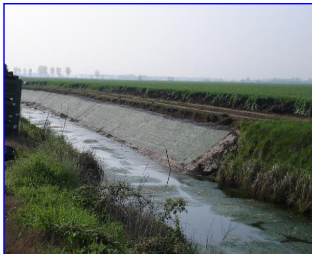
Foto 2 - Intervento di consolidamento e protezione antinutria/antigambero su Canale Molinella, MN (gentilmente Consorzio Bonifica Fossa Di Pozzolo - Mantova, Direttore Dott. Cesare Bozzacchi, Ing. Oliviero Zucchini)
