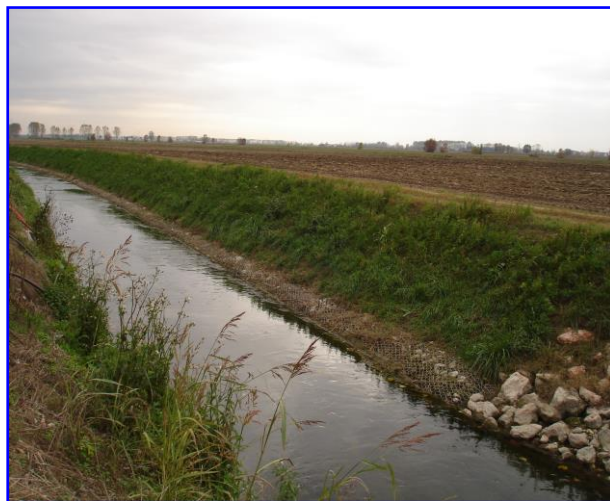
Foto 3 - La foto illustra la situazione del canale a sette mesi dalla realizzazione dell'intervento. La tipologia di geocomposito utilizzata antinutria/antigambero è in rete metallica in maglia 6x8 filo 2.20/3.20 ZN.AL5% e plasticata preaccoppiato con georete tessura in PET ad alta tenacità (maglia 3x3mm)
