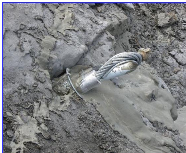
Foto 6 – Dettaglio dell'imboccatura del foro dopo la cementazione. Si nota il collarino antitaglio
