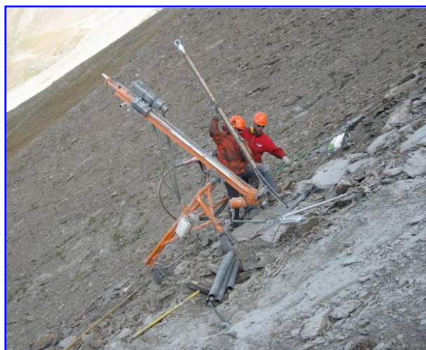
Foto 5 – Cantiere alpino in materiale litoide fratturato; infissione del tubo stabilizzatore contenente un tirante in
