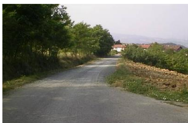
▲ Strada interpodereale: terminazione sinistra della gabbionata
