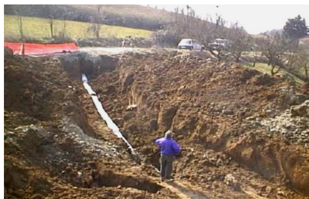
▲ Panoramica della ricostruzione del pendio
