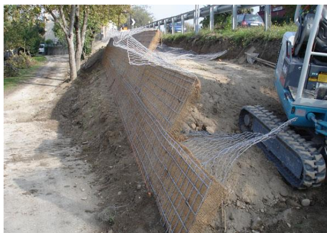
▲ Assemblaggio degli elementi e stesa del terreno
