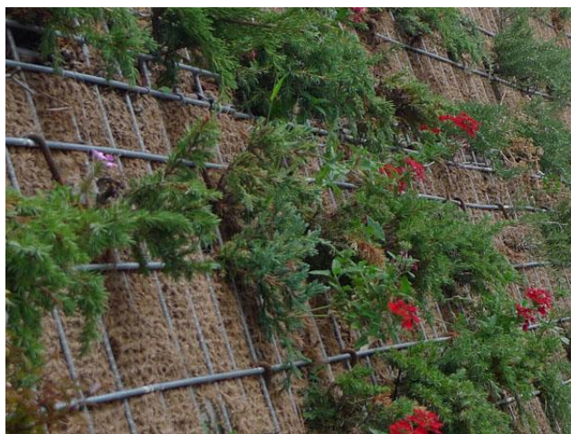
▲ Paramento frontale in fase di rinverdimento
