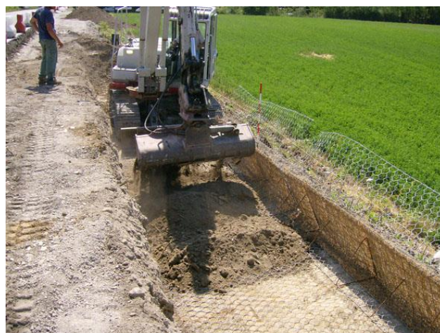
▲ Realizzazione del rilevato in terra rinforzata
