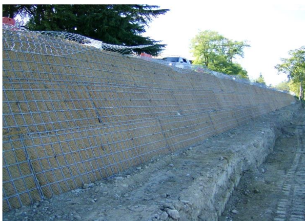
▲ Avanzamento dei lavori fino alla quota di progetto
