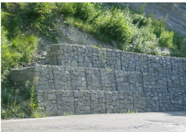
▲ Muro in gabbioni chiodati a lavori terminati
