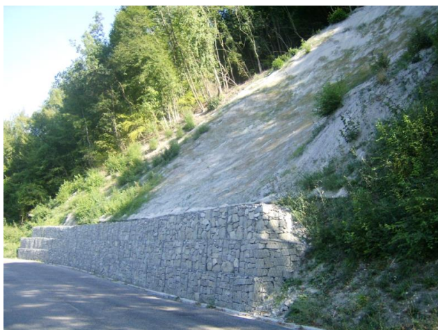
▲ Vista d'insieme dell'opera dalla strada
