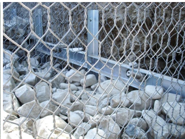
▲ Piastrine di ancoraggio e chiodatura dei gabbioni
