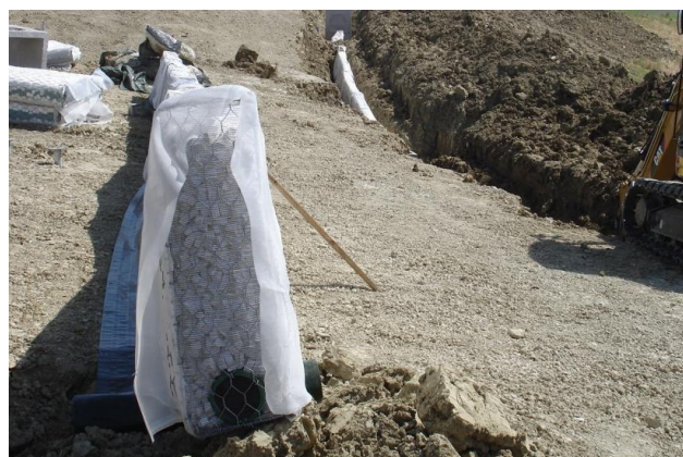
▲ Costruzione del collettore di base pannello con tubo dreno interno
