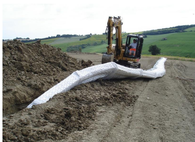
▲ Alloggiamento dei GABBIODREN® in trincea
