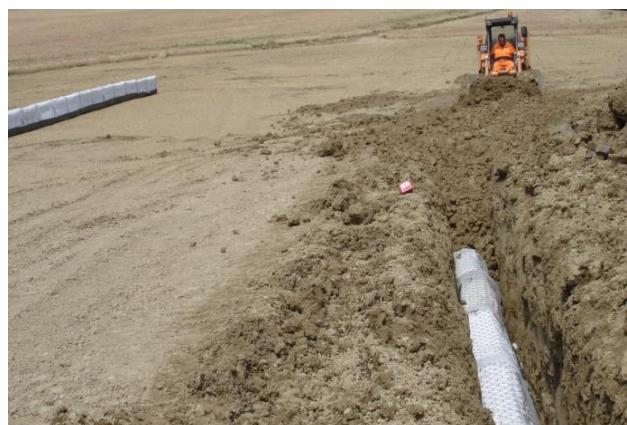
▲ Ricopertura delle linee drenanti in GABBIODREN® con il terreno di scavo
