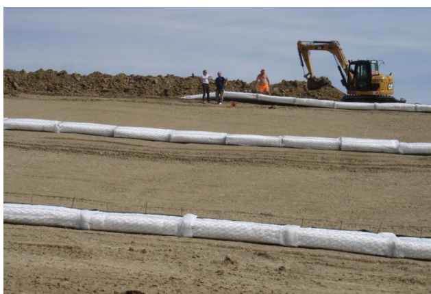
▲ Montaggio dei GABBIODREN® per file parallele
