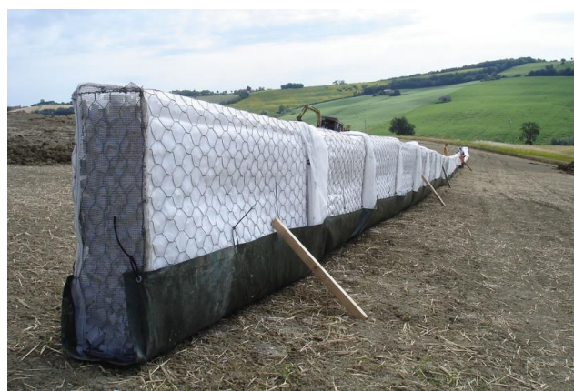
▲ Assemblaggio e costruzione dei bracci drenanti
