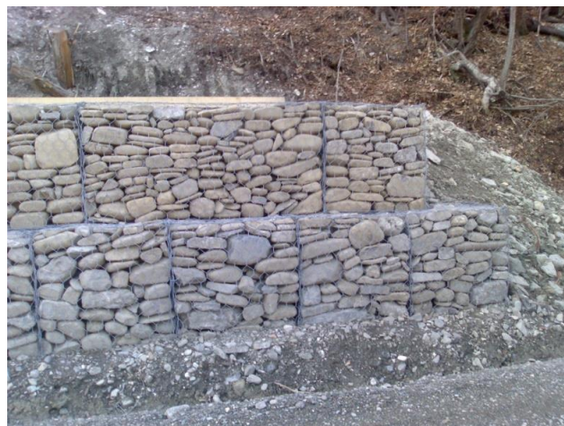
▲ Base della scarpata realizzata in gabbioni chiodati
