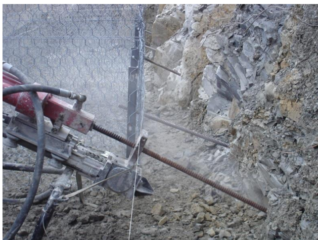
▲ Fase di realizzazione dei fori per le chiodature
