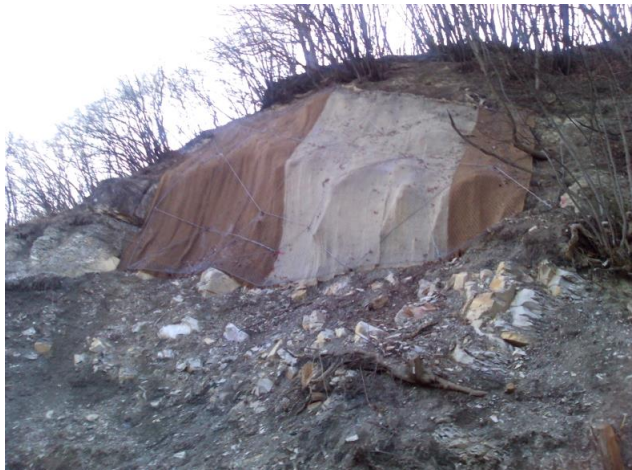
▲ Parte apicale della scarpata con rinforzo corticale in R.E.C.S.®, chiodi e funi
