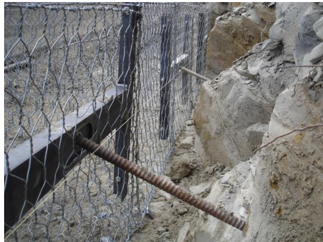
▲ Vista posteriore dei gabbioni chiodati
