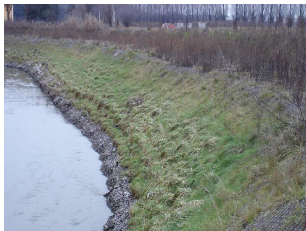
▲ Aspetto del canale ad un anno dalla fine dei lavori
