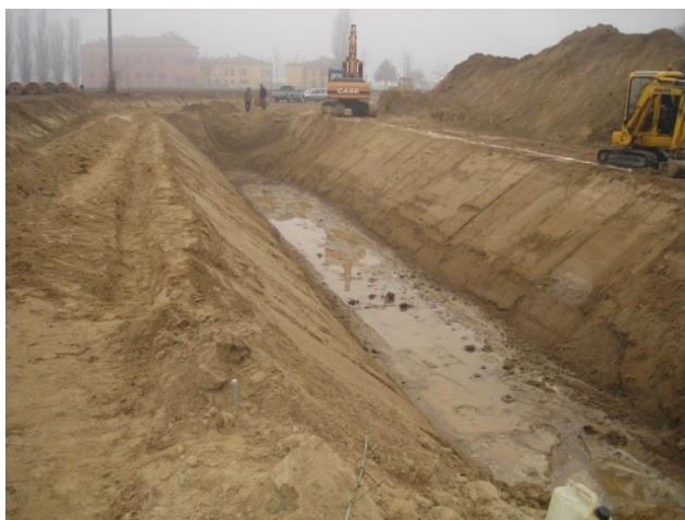
▲ Fasi di scavo e sagomatura del canale
