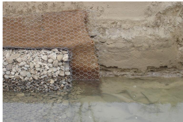
▲ Particolare TNT separatore, materasso metallico e rinalzo del R.E.C.S.® IDRO al di sotto di esso
