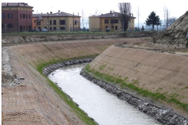
▲ Ultime fasi di rivestimento delle sponde
