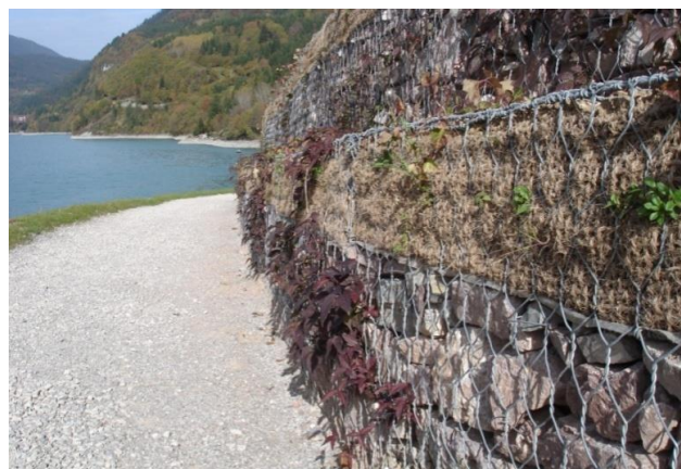
▲ Gabbioni in fase di rinverdimento a lavori ultimati
