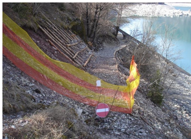
▲ Situazione della pista prima dei lavori
