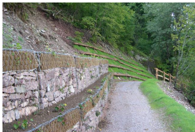
▲ Situazione della pista a lavori ultimati
