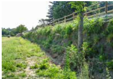
Impiego del sistema preassemblato FAST-TER nella realizzazione di una pista ciclabile in allungamento stradale di sottoscarpa
