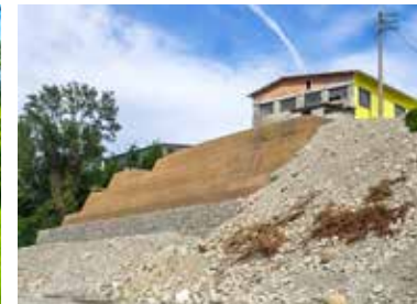
Ricostruzione del profilo spondale con Sistema FAST-TER con base in gabbioni e contestuale recupero del piazzale a monte
