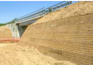
Rilevato stradale di sottoscarpa in terre rinforzate FAST-TER
