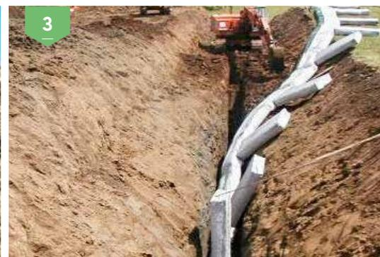
Avanzamento dello scavo e contestuale posa della linea drenante assemblata in sicurezza
