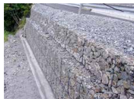
Opera di consolidamento di sottoscarpa stradale in Nail - Gabions
