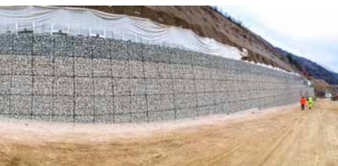
Protezione di scarpata con muro in Nail Gabions sub-verticale (Francia)
