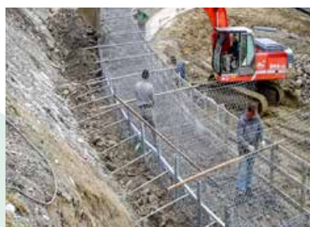
Fase realizzativa di un'opera di sostegno di sottoscarpa stradale in Nail Gabions
