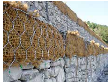
Particolare del gabbione verde dopo la sua realizzazione
