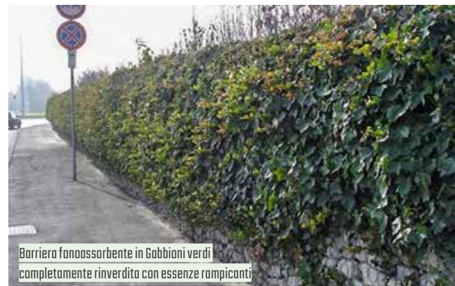
Gabbionata verde a protezione della pista ciclabile - Calazio Corte (LC)
