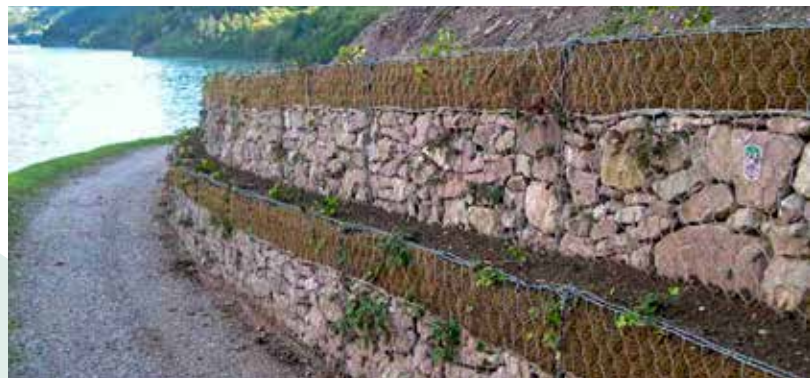
Gabbionata verde a protezione della pista circumlacuale (Lago di Molveno - TN)
