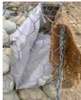
Foto della tasca vegetativa ancora da riempire, inserita all'interno del gabbione
