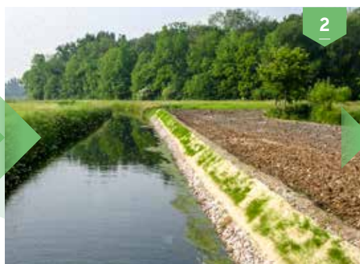
Opera finita dopo un mese dal termine dei lavori, inizia la germinazione (n.b.: si è eseguita solo una leggera semina a spaglio)
