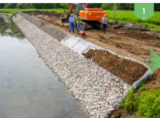
Fasi di posa in opera del Materasso MATECO®, riempimento differenziato delle tasche con pietrame e con terreno vegetale
