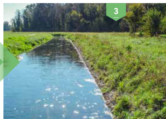
Opera rinverdita a 5 mesi dal termine dei lavori
