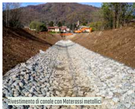
Rivestimento completo del fondo di un torrente alpino
