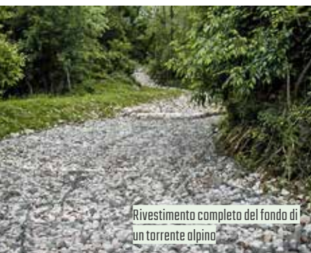
Rivestimento di canale con Materassi metallici
