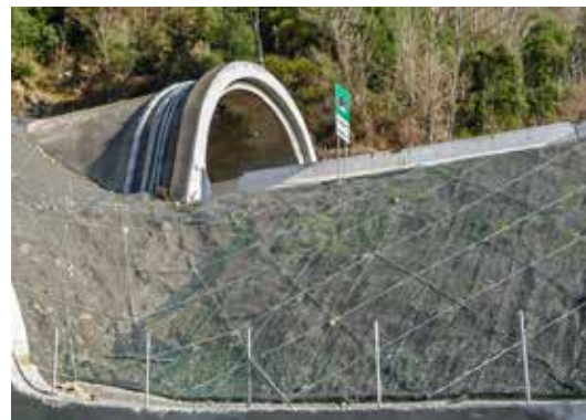
Applicazione del Sistema RECS GS in ambito autostradale ancorato con chiodi e funi diagonali
