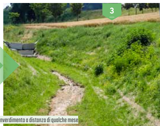
Intervento di protezione spondale con RECS IDRO lungo il Fiume Po con presidio al piede in terra rinforzata Fast Ter
