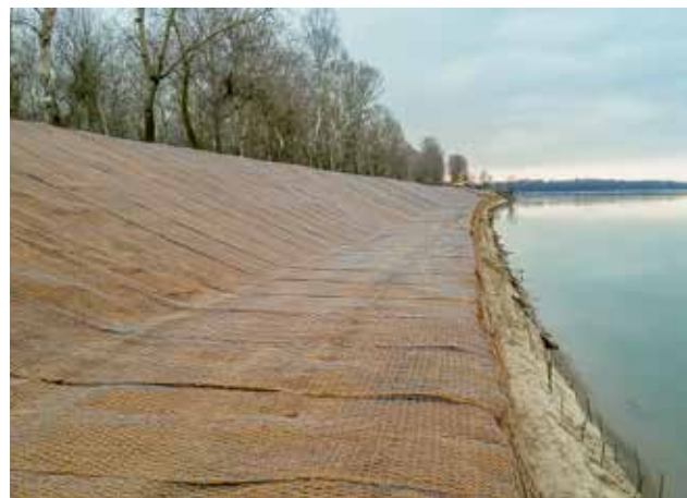
Intervento di protezione spondale con RECS IDRO lungo il Fiume Po con presidio al piede in terra rinforzata Fast Ter
