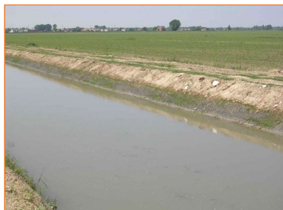
▲ Sistemazione del terreno vegetale sul Geocomposito RECS a fine lavori
