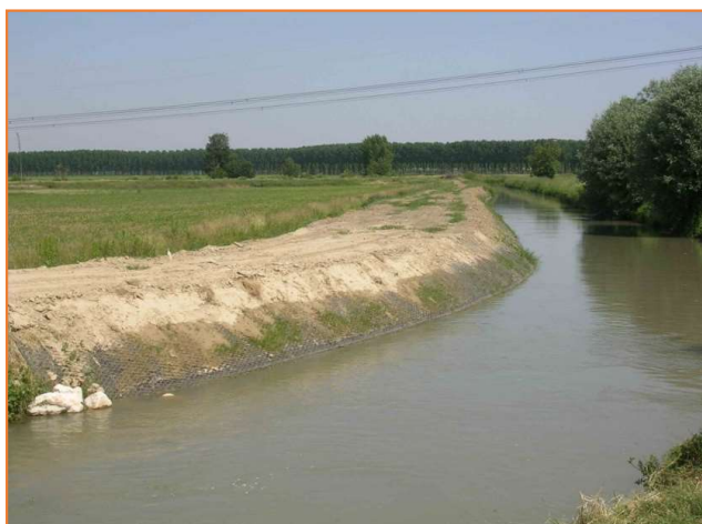
▲ Spalmatura di terreno vegetale sul Geocomposito
