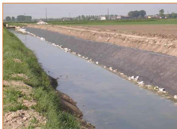
▲ Fasi di scavo e posa del Geocomposito RECS
